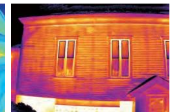
Диагностика зданий и сооружений
